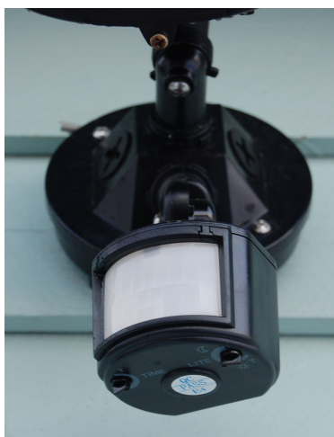
รูปที่ 2.7.2.1: เครื่องตรวจจับการเคลื่อนไหวแบบ PIR ใช้สำหรับควบคุมไฟภายนอกอาคารแบบอัตโนมัติ
