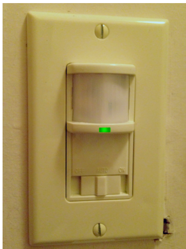
รูปที่ 2.7.2.3: สวิตช์ไฟภายในอาคารที่ติดตั้งเซ็นเซอร์ตรวจจับการเคลื่อนไหวแบบ PIR
